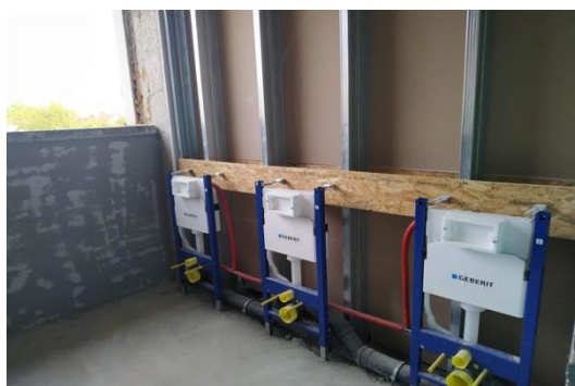
Slike 249. – 254.: Radovi na obnovi zgrade Učiteljskog fakulteta - Odsjek u Petrinji
