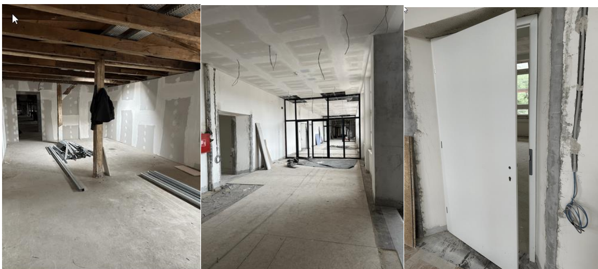
Slike 183. - 189.: Cjelovita obnova zgrade Učiteljskog fakulteta u Zagrebu tijekom travnja 2024.
