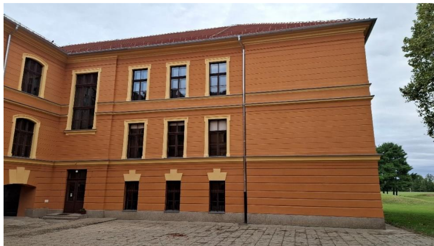
Slike 269. – 274.: Obnovljena pročelja zgrade 1, spojnoga dijela i zgrade 2
